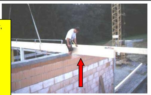
Bild 2 zeigt >Gareilbinder<. Eine Konstruktion, die statisch selbsttragende Bauteile darstellen. Entscheidend ist, dass alle statischen Kräfte, die diese Fertigbauteile verarbeiten müssen, immer auf dem Balkenaufleger die Kräfte in die Wände, Pfeiler, Stützen und Gegenlager, auf die Fundamente abtragen. Siehe roter Pfeil.
