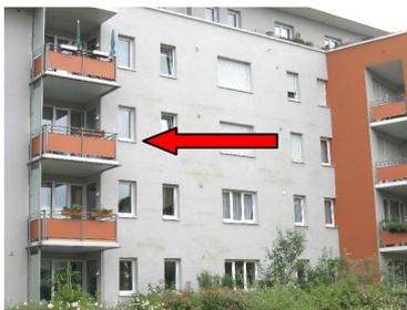
Rot sehen wir eine Balkonbrüstung aus einer Kombination aus verzinktem Stahl und Fassadenplatten. Eine der meist gesehene Varianten von Balkonbrüstungen. Im Volksmund werden diese Bauteile auch Balkongeländer bezeichnet.
