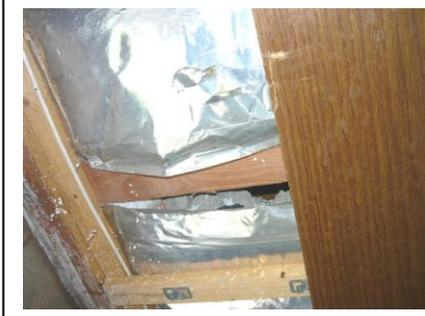
Die gebräuchlichste Dämmung finden wir auf unseren Baustellen in Form von Glasfasermatten. Meist kaschiert mit Aluminium um gleichzeitig eine Dampfsperre im Dach mit zu integrieren. Die Alukaschierung wird auf der Innenseite des Daches aufgebracht. Varianten finden wir in der Steinwolle. Zu beachten bleibt, dass dem gehobenen Brandschutz hauptsächlich die Glas- oder Steinwolle zugeteilt wird.
