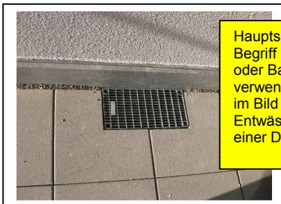
Hauptsächlich wird der Begriff bei Flachdächern oder Balkonen verwendet. Hier sehen wir im Bild den Einlauf in ein Entwässerungssystem einer Dachterrasse.
