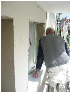
Das Bild zeigt ein Hausverputz. Aus Sackwaren, wird ein Brei von Putzmörtel angerührt, mit dem dann die Rohbausteine des Hauses verputzt werden. Zwischenzeitlich werden Putze auch auf Trägermaterialien wie Weichfaserplatten und Spanplatten aufgebracht. Diese Technik finden wir im Fertighausbau. Dort werden Holzmaterialien verputzt. Bei größeren Objekten kommt der Putz in Silos auf die Baustelle. Aufgebracht wird der Putz dann im Spritzverfahren.
