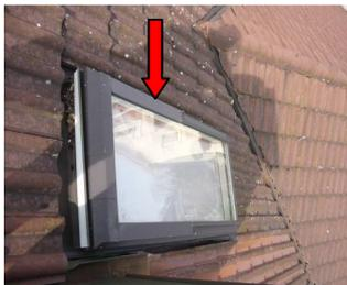
Hier im Bild sehen wir jetzt ein Dachflächenfenster. Wenn das Grundfenster im Dach eingebaut ist, wird von außen der Eindeckrahmen über das Fenster geschoben und mit dem Dachflächenfenster und dem Dach montiert. Dabei stellt der Eindeckrahmen die 1. Entwässerungsebene des Dachflächenfensters dar.
