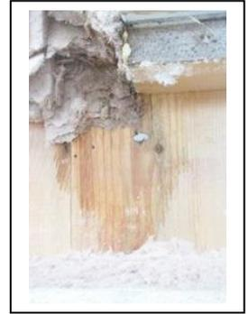
Ohne eine 2. Entwässerungsebene unter der Fensterbank produzieren wir diese Schäden:
