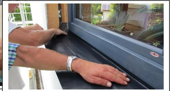
Die Membrane muss über den Putz geführt werden oder auf einer Putzleiste enden:
