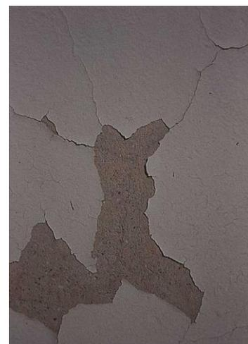
Deutlich zu erkennen, dass die Farbe mit ihrer Oberflächen-Spannung, den gesamten Untergrund mit zerriss. Bei einer Fuge im Trockenbau ist das ebenso gelagert. Diese muss - mit dem geplanten Wandbelag, in eine entsprechende Qualitätsgruppe vorgegeben werden *Q1, Q2, Q3, Q4*.
