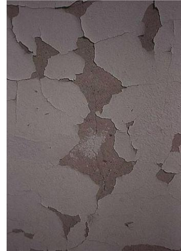
Hier sehen wir eine zerrissene Wandfassade, die dem „kalten Fluss“ zum Opfer fiel. Die Wandfarbe harmonierte nicht mit dem Untergrund „Putz“ und sprengte somit aufgrund der Oberflächenspannung die gesamte Fassade. Ein Schaden, den wir Sachverständige täglich sehen. Ein Mangel der eindeutig in der Gesamtorganisation des Objekts zu suchen ist. Derjenige, der diesen Putz und diese Oberfläche zusammenführte, steht hier in der Verantwortung.
