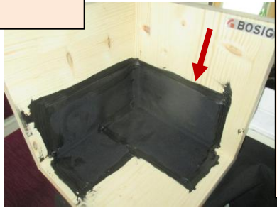
Bild 25: Das Endergebnis: So hat eine Ecke des Bauwerksanschlusses aussehen. Wenn es die Grundlage der Planung hergibt, muss nach DIN 18195 die Aufkantung, siehe roter Pfeil, bis auf FFB 150 mm hochgeführt werden oder an die Fenster und Haustüren angeschlossen werden. Diese Grundlage ist aber Naturwissenschaftlich so alt wie die >Römer Häuser< gebaut haben.
