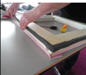
Bild 21: Zwischenzeitlich sind wir bei der >Königsklasse< des Fensterbaus am Simulator angekommen. Dem Fenstereinbau in einer Klinkerfassade mit Luftschicht. Also letztendlich bei einer Vorsatzschale als zwei Mauer-schalenwerk. Das Bild als Schnappschuss soll aufzeigen, wie selbst der Referent hier ins Nachdenken kommt, damit der Fenstereinbau in dieser Luftschicht auch Schadensfrei vorgenommen werden kann. Hier ist denken angesagt.
