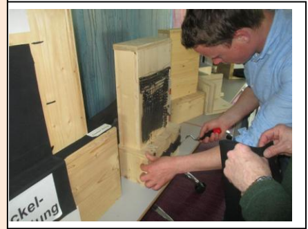
Bild 23: Rot sehen wir jetzt, wie wir mit dem System Fasatan und Fasaty natürlich auch Bauwerksabdichtungen vornehmen können. Die Teilnehmer haben dieses Muster im Seminar selber hergestellt. Wir erkennen, dass wir somit die Bauwerksabdichtung im gleichen Zuge mit Fenstereinbauprodukten herstellen und ergänzen können. Immer nach den Ansprüchen der DIN 18195 mit Raupenklebung oder Vollflächenverklebung mit dem Fasatan TFS Kleber verklebt.
