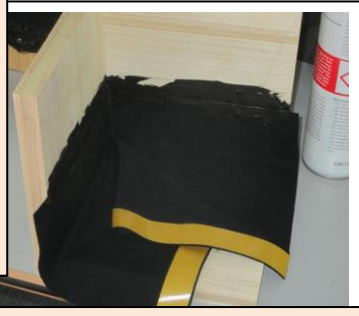
Bild 25: Das Endergebnis: So hat eine Ecke des Bauwerksanschlusses aussehen. Wenn es die Grundlage der Planung hergibt, muss nach DIN 18195 die Aufkantung, siehe roter Pfeil, bis auf FFB 150 mm hochgeführt werden oder an die Fenster und Haustüren angeschlossen werden. Diese Grundlage ist aber Naturwissenschaftlich so alt wie die >Römer Häuser< gebaut haben.
