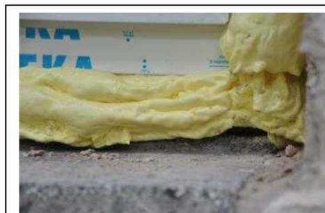
Oben erkennen wir, wie ohne dem Säubern der Brüstung und Laibungen einfach nur mit einer Benässung eingeschäumt wurde. Eine Luftdichte Haftung kann so nie entstehen. Links erkennen wir, welche Dimensionen von Fugenbreiten hier überbrückt werden mussten. Dafür sind keine Zulassungen für diesen Schaum vorhanden. Die max. Fugenbreite dürfte lediglich 15 mm betragen. Siehe Zulassung Anlage 5.
