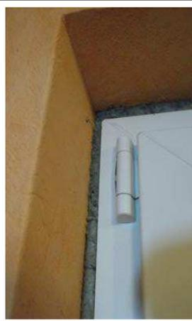
Grundlegend ist, dass der Bauschaum 167 er bei der Montage benässt wurde. Allerdings muss davon ausgegangen werden, dass nach diesen Fotos des Einbaus, der Schaum gar nicht zu seiner Reife gekommen ist. Das wiederum heißt, dass er letztendlich auch die Verbindung zum Mauerwerk keine Verbindung herstellen kann damit er die Luftdichtheit halten kann.
