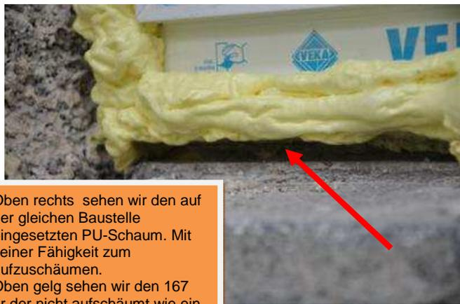
Oben rechts sehen wir den auf der gleichen Baustelle eingesetzten PU-Schaum. Mit seiner Fähigkeit zum aufzuschäumen. Oben gelg sehen wir den 167 er der nicht aufschäumt wie ein PU-Schaum sondern staucht. Und somit keine Verbindung mit der 2. Flanke ingeht.
