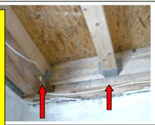
Balkenschuhe sind statische Bauteile. Meist werden diese genagelt oder geschraubt. Die Anzahl der Nägel und Schrauben muss dabei von einem Statiker auf die entsprechende Lastaufnahme berechnet werden.
