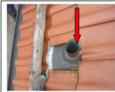
Entscheidend ist, dass unsere Abwasserentsorgung unseres Gebäudes naturwissenschaftlich nur funktionieren kann, muss beim Spülen der Kloschüssel beispielsweise dem Abwassersystem Luft zugeführt werden. Daher muss in diese Öffnungen in verwirbelnder Weise, Luft einströmen können. Ansonsten kann das Entwässerungssystem nicht funktionieren. Hier der Luftzufluss über das Dach.
