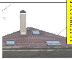
Auch in Sanierungen finden wir heute noch Einfachdeckungen. Wenn der alte Dachstuhl nicht nachsaniert wird und eine doppelte Deckung vom Gewicht her für die alte Dachkonstruktion statisch nicht ausgelegt ist. Entscheidend ist dann, dass ein dichtes Unterdach eingebaut werden muss.
