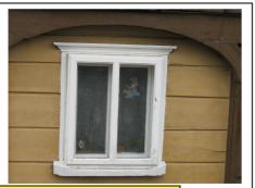
Hauptsächlich finden wir solche Verglasungen bei >Kastenfenster. Hierbei wird lediglich ein Flügel mit einer einfachen 3-5 mm Floatglasscheibe verglast. Für die Wintermonate wurden bei diesen Einfachverglasten Scheiben Vorfenster angehängt. Ein weiterer Flügel mit einer Einfachverglasung wurde einfach nochmals vor das Fenstersystem gehängt. Hier ein Kastenfenster mit einem Winterfenster vorgehängt.
