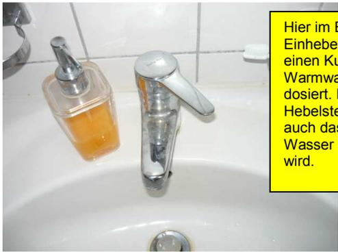
Hier im Bild eine typische Einhebelmischbatterie. Über einen Kugelkopf, wird Kalt- und Warmwasser automatisch dosiert. Das heißt, dass mit der Hebelstellung des Mischers auch das kalte und warme Wasser immer gleich gemischt wird.
