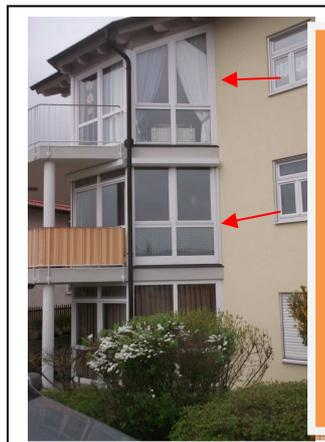
Solche, mit dem roten Pfeil angezeigten Elemente, mit Fensterflügeln auf der oberen Elementseite, können nicht mehr mit handelsüblichen Fenstereinbauschrauben befestigt werden. Hier müssen Nachweise geführt werden, dass diese Schrauben eine >bauaufsichtliche Zulassung < im Absturzbereich haben. Hat die Schraube dies nicht, steht der Handwerker mit einem Fuß im >Zuchthaus<. Spannend auch, wie der Planer diese Situation lösen wird? Es wird spannend werden beim Seminar bei der Firma Würth.
