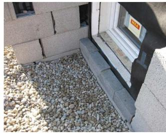
Das Bild zeigt einen Lichtschacht mit einem Fenster in einen unbeheizten Kellerraum. Hier liegt das bauphysikalische Gefälle meist so, dass die Abwanderung nach innen erfolgt. Hier kann nur empfohlen werden gerade mit semipermeable – Membranen die Fugenabdichtung vorzunehmen. Ein Einsatzgebiet bei dem das TwinAktiv ME500 von Illbruck hervorragend geeignet ist. Das Gefälle innen dichter wie außen, wäre hier mit einem Bauschaden behaftet. Gleiches gilt bei den Innenelementen eines Hallenbades.
