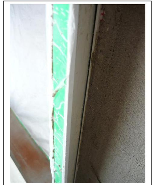
Links sehen wir jetzt die Auskleidung, wie sie aus dem LF vorgegeben wird. Rechts sehen wir jetzt, dass mit der Schiene und der Bauwerksabdichtung unterhalb des Fensterbankes eine Entwässerungsebene entsteht bei der das Wasser auch ablaufen kann.
