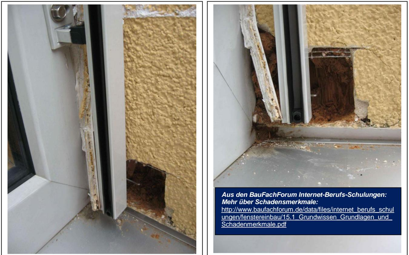
Links erkennen wir jetzt einmal eine solche APU-Leiste auf einer Aluschale. Das wird nach der PR im täglichen Gebrauch zwischenzeitlich von den Putzern als >Standard der Technik< als auch >anerkannten Regeln der Technik< ausgelegt. Und das muss zum Wohle der Bausubstanz und des Endverbrauchers verhindert werden. Rechts sehen wir nach 2 Jahren, dass sich die Leisten ohne Kleberückstände zu finden löst. Das verfaulte Holz nach 5 Jahren sollte selbst den Schreibtisch-Autoren zu denken geben.
