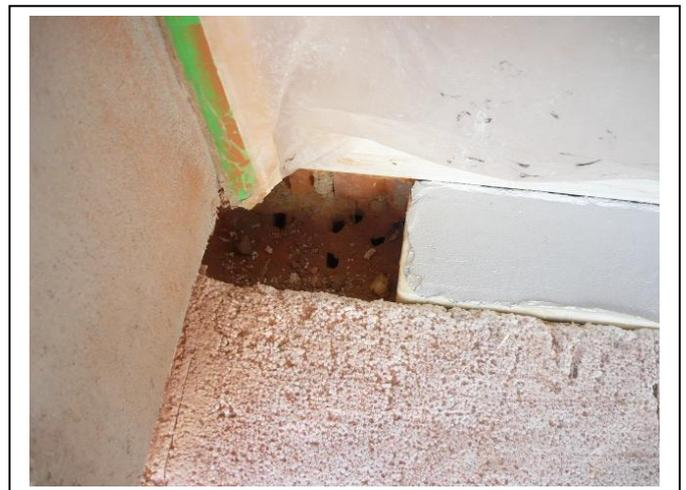
Links sehen wir jetzt einmal während der Montage eines WDVS dass der Putzer nicht einmal die Dämmung an das Fenster anschließt. Da müssen dann in der Rohbauzeit Anwälte eingeschaltet werden, damit der Putzer auf die Sanierung des SV wie rechts zu sehen, das Mauerwerk ausspitzt und den Dämmanschluss vornimmt. So, wie dies aus seiner geschuldeten Leistung dem Bauherrn gegenüber vereinbart wurde.
